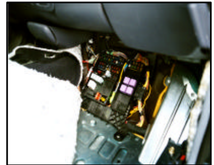
Anschluss der Stromversorgung
