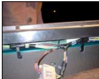
Anschluss des E-Satzes, Kabelverlegung Heck mit Kompaktstecker
