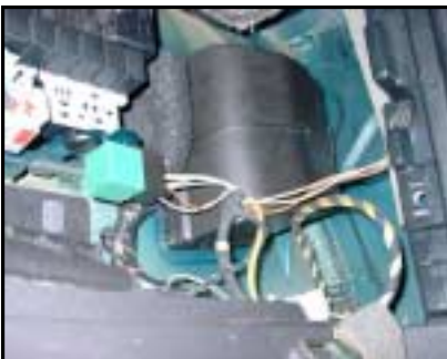
Anschluss des E-Satzes, Kabelstrang links
